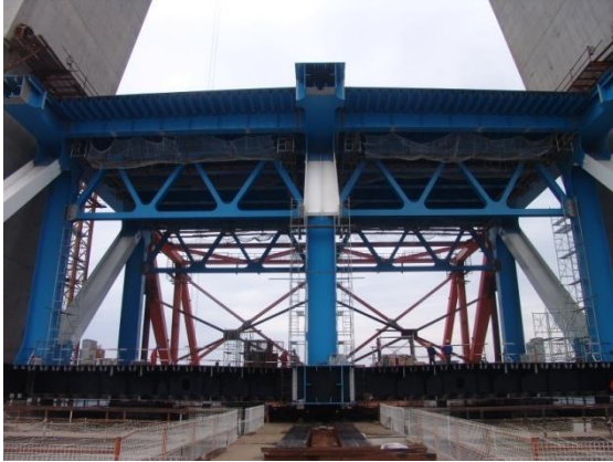
图 3 箱桁组合断面构造
